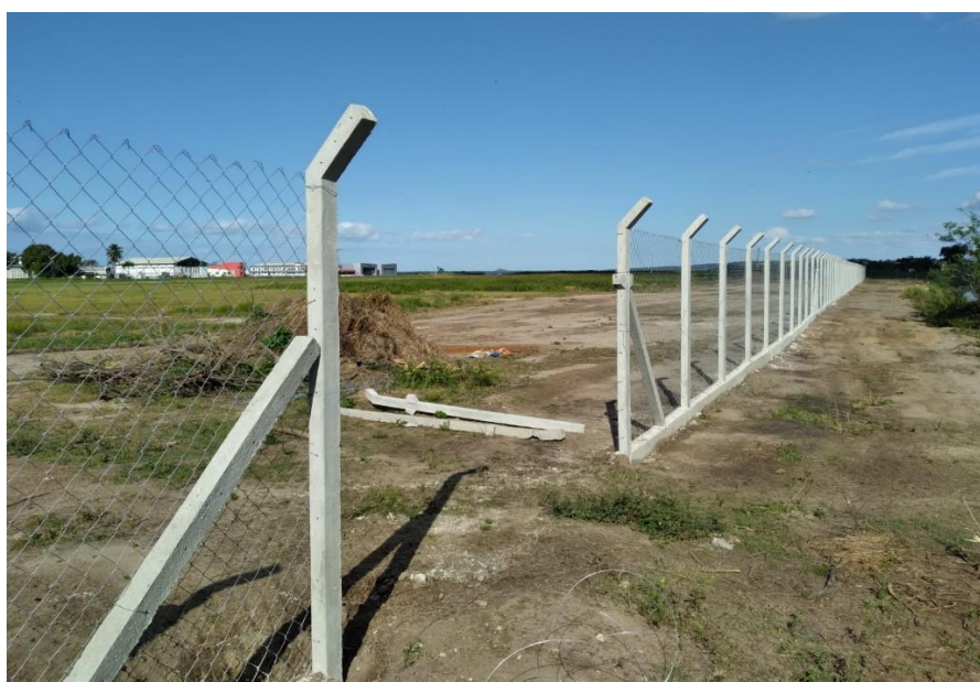
Figura 37: Cerca operacional sendo construída.
